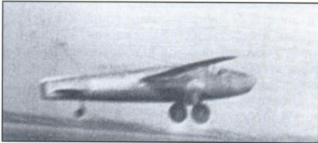
Экспериментальный самолет He-178 – первый, полетевший с турбореактивным двигателем
